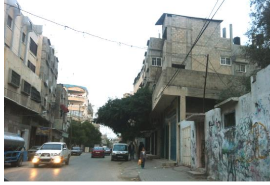
شكل 5-20 صورة توضح شارع يافا أحد الشوارع الهامة في حي التفاح
